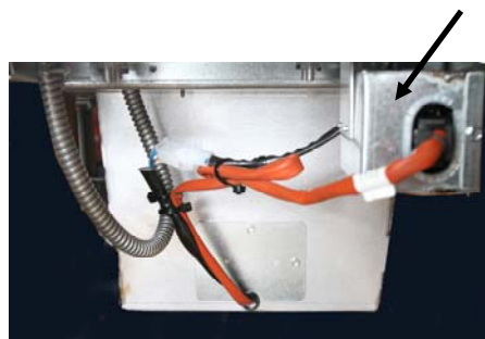
Figura 3: Ligue o conector preto na caixa de utilidade como mostrado. Um chicote de fios separados com uma ficha branca, se presente, não é usado.
